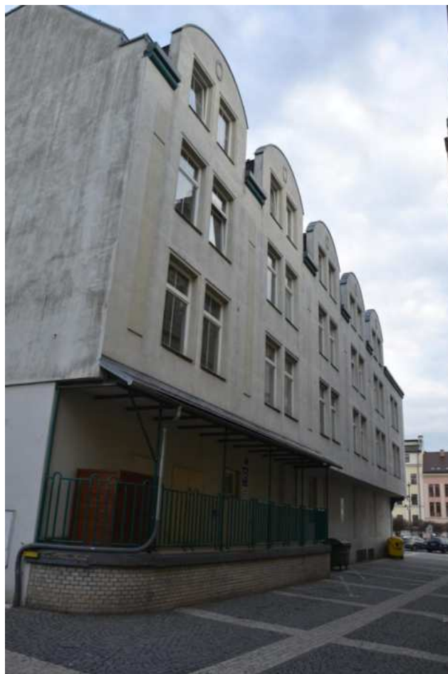
Dům č. p. 92, boční západní průčelí, foto IP 2013.
