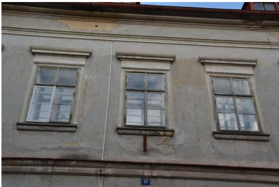
Dům č. p. 97, hlavní západní průčelí, oken v patře, foto IP 2013.
