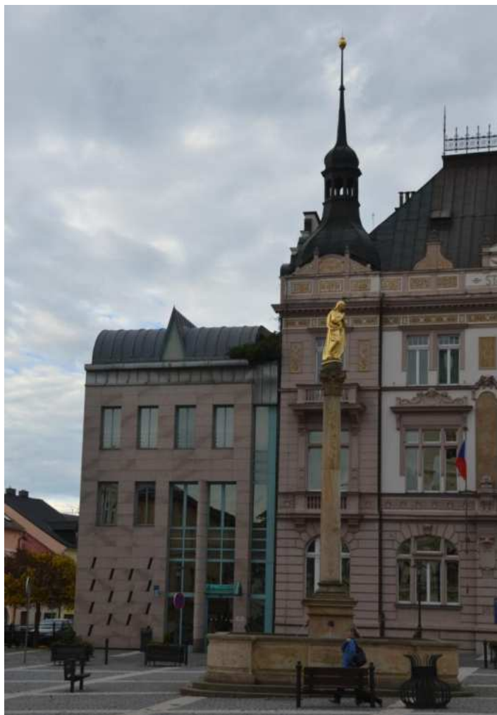
Dům č. p. 94, přístavba spořitelny na místě č. p. 95, foto IP 2013.
