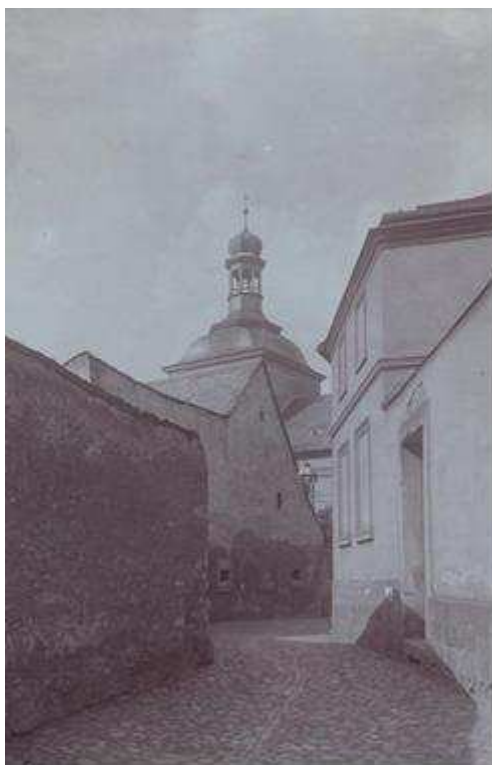
Dům č. p. 92, zadní západní průčelí domu kolem roku 1900, (foto sbírka MČR, inv. č. AFT 357).
