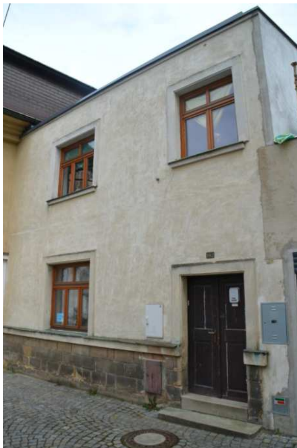
Dům č. p. 882, hlavní západní průčelí, foto IP 2016.
