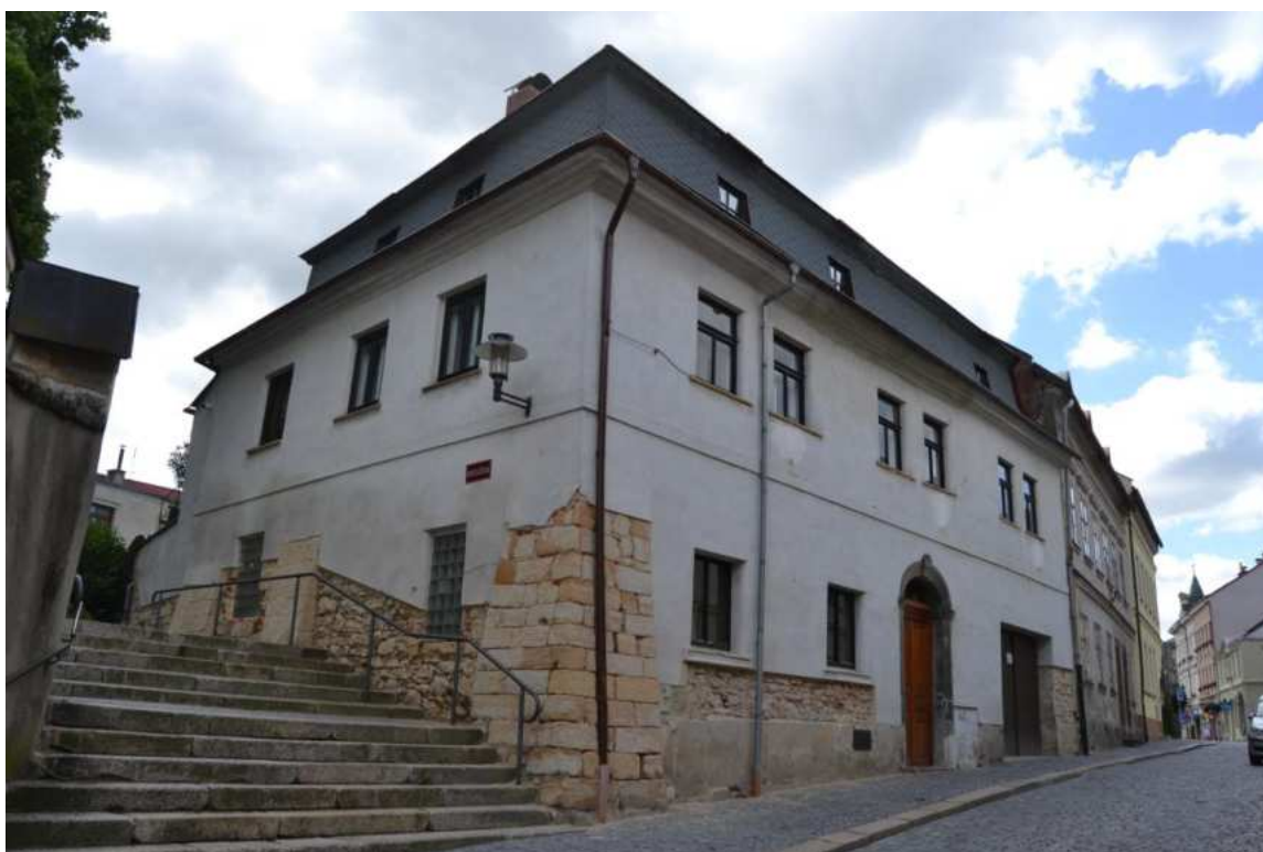
Dům č. p. 98, osekáné průčelí domu s převládajícím lomovým pískovcovým zdivem a mladšími opěráky z pískovcových kvádrů, foto IP 2015.
