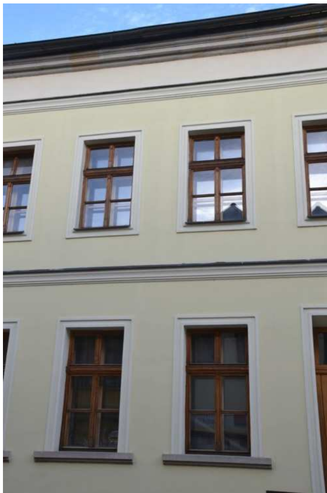
Dům č. p. 1425, hlavní západní průčelí, detail oken, foto IP 2013.
