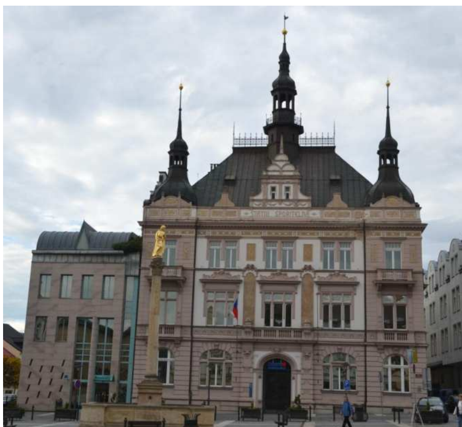
Dům č. p. 94, hlavní jižní průčelí, foto IP 2013.
