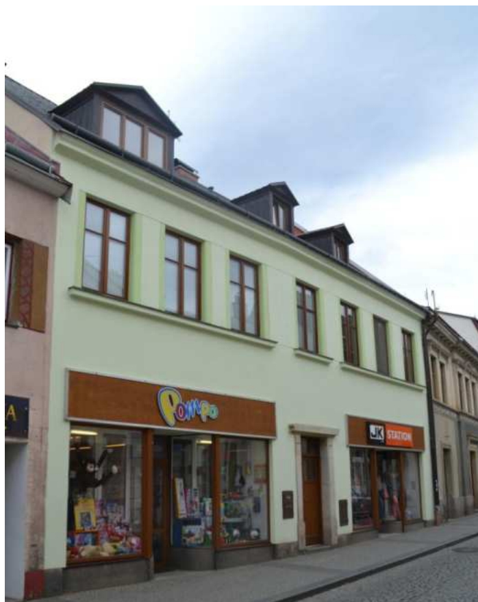
Dům č. p. 90, hlavní východní průčelí po obnově, foto IP 2016.
