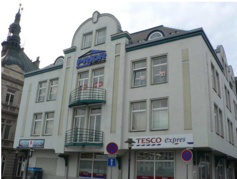
Dům č. p. 92, hlavní jižní průčelí, foto MK 2013.
