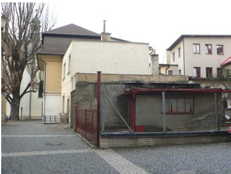
Dům č. p. 408, jižní průčelí, foto MK 2013.
