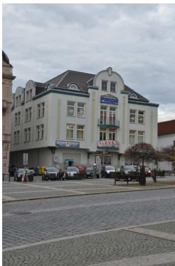
Celkový pohled na jižní průčelí domu č. p. 92, foto IP 2013.
