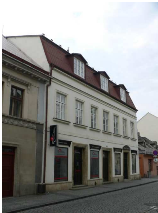
Dům č. p. 88, hlavní východní průčelí, foto MK 2013.
