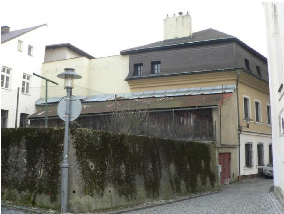
Dům č. p. 88, přístavba kolny, foto MK 2013.
