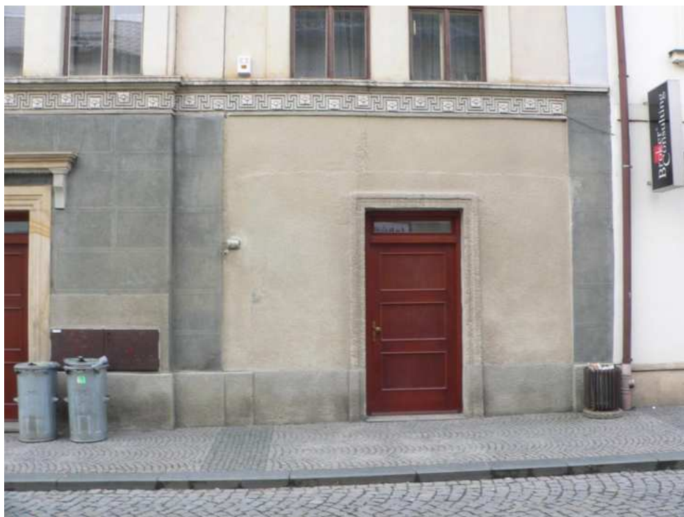
Dům č. p. 89, hlavní východní průčelí, detail fasády, foto MK 2013.
