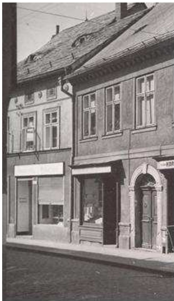
Průčelí domu č. p. 92 (druhé zprava) v roce 1944., (foto sbírka MČR, inv. č. AFT 179_2009-02).
