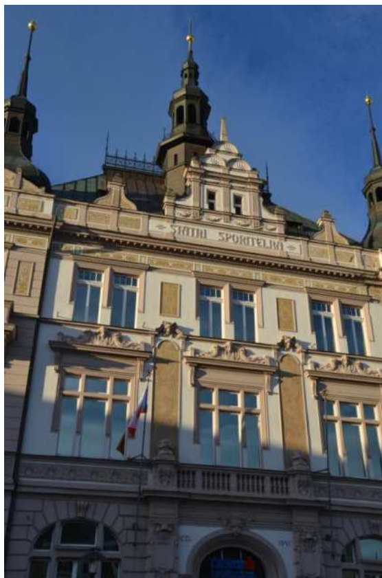
Dům č. p. 94, detail fasády horních podlaží u hlavního jižního průčelí, foto IP 2013.
