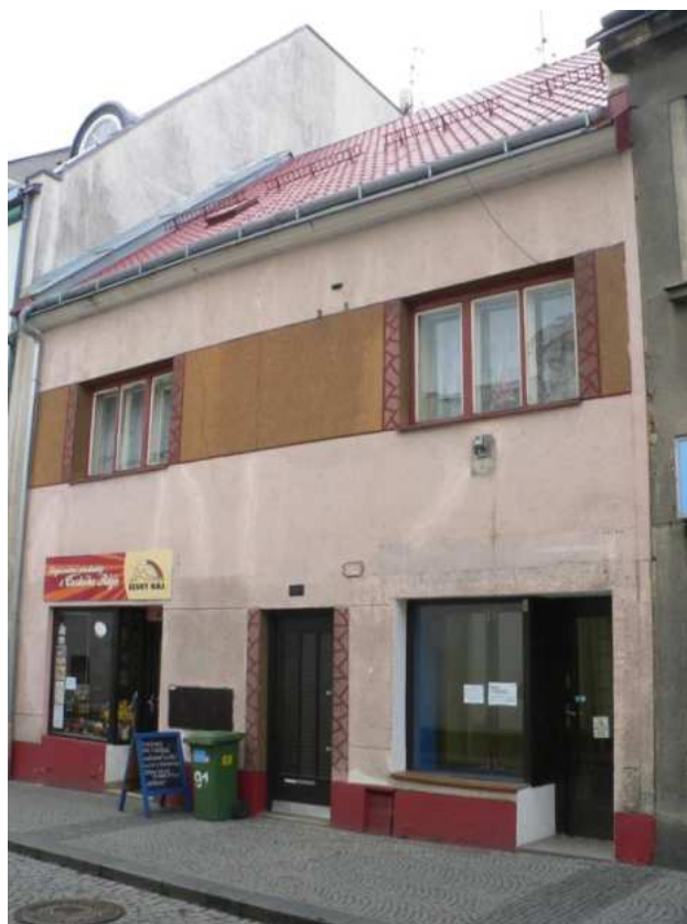
Dům č. p. 91, hlavní východní průčelí, foto MK 2013.
