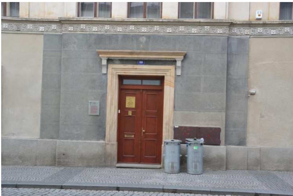
Dům č. p. 89, hlavní východní průčelí, detail portálu, foto IP 2013.
