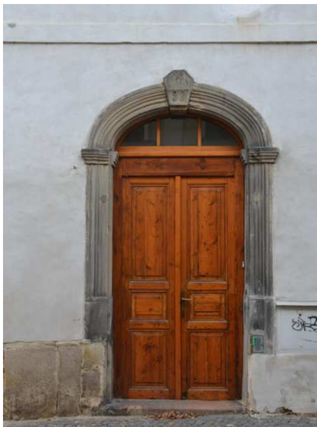
Dům č. p. 98, hlavní západní průčelí, detail portálu, foto IP 2013.
