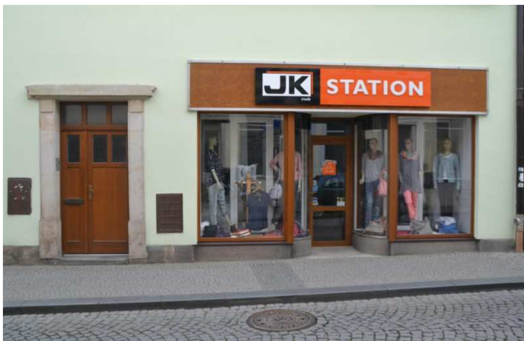
Dům č. p. 90, hlavní východní průčelí po obnově, detail portálu a výkladce s novým obložením, foto IP 2016.
