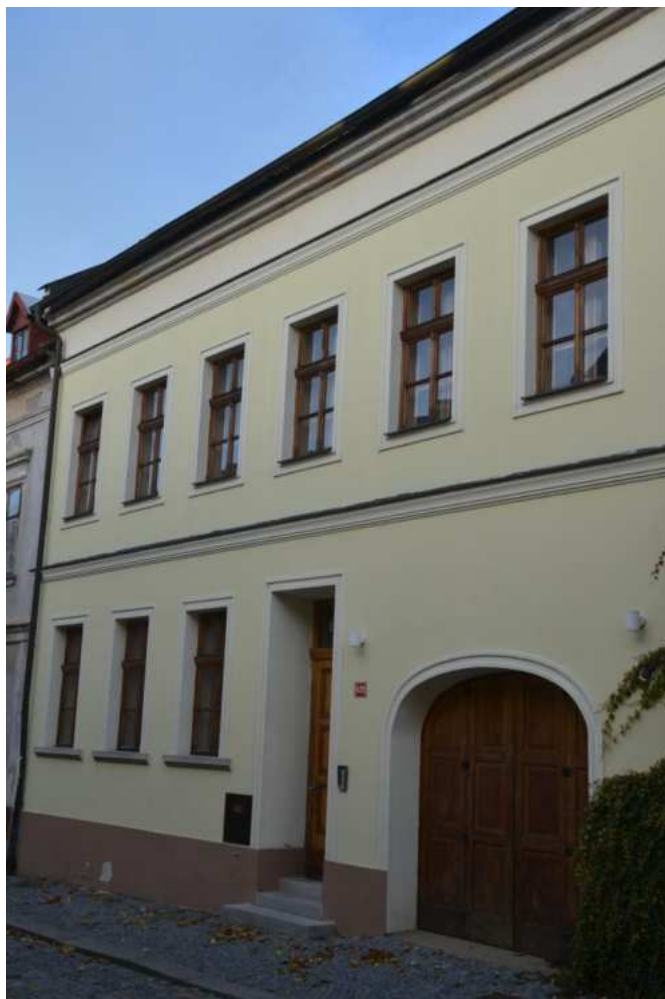
Dům č. p. 1425, hlavní západní průčelí, foto IP 2013.
