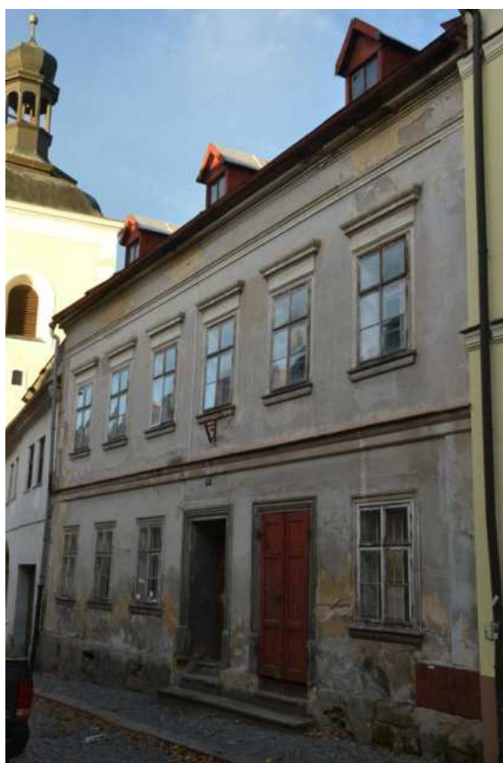
Dům č. p. 97, hlavní západní průčelí, foto IP 2013.
