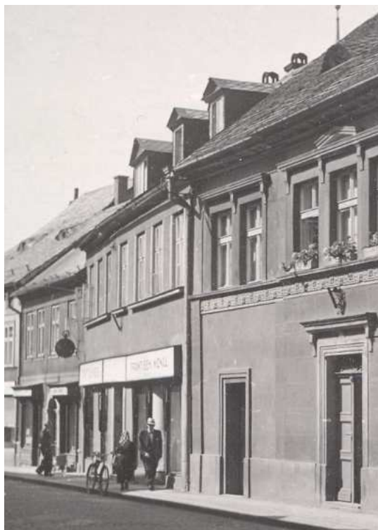
Průčelí domu č. p. 90 (druhé zprava) v 1. pol. 20. stol., (foto sbírka MČR, inv. č. AFT 991a).
