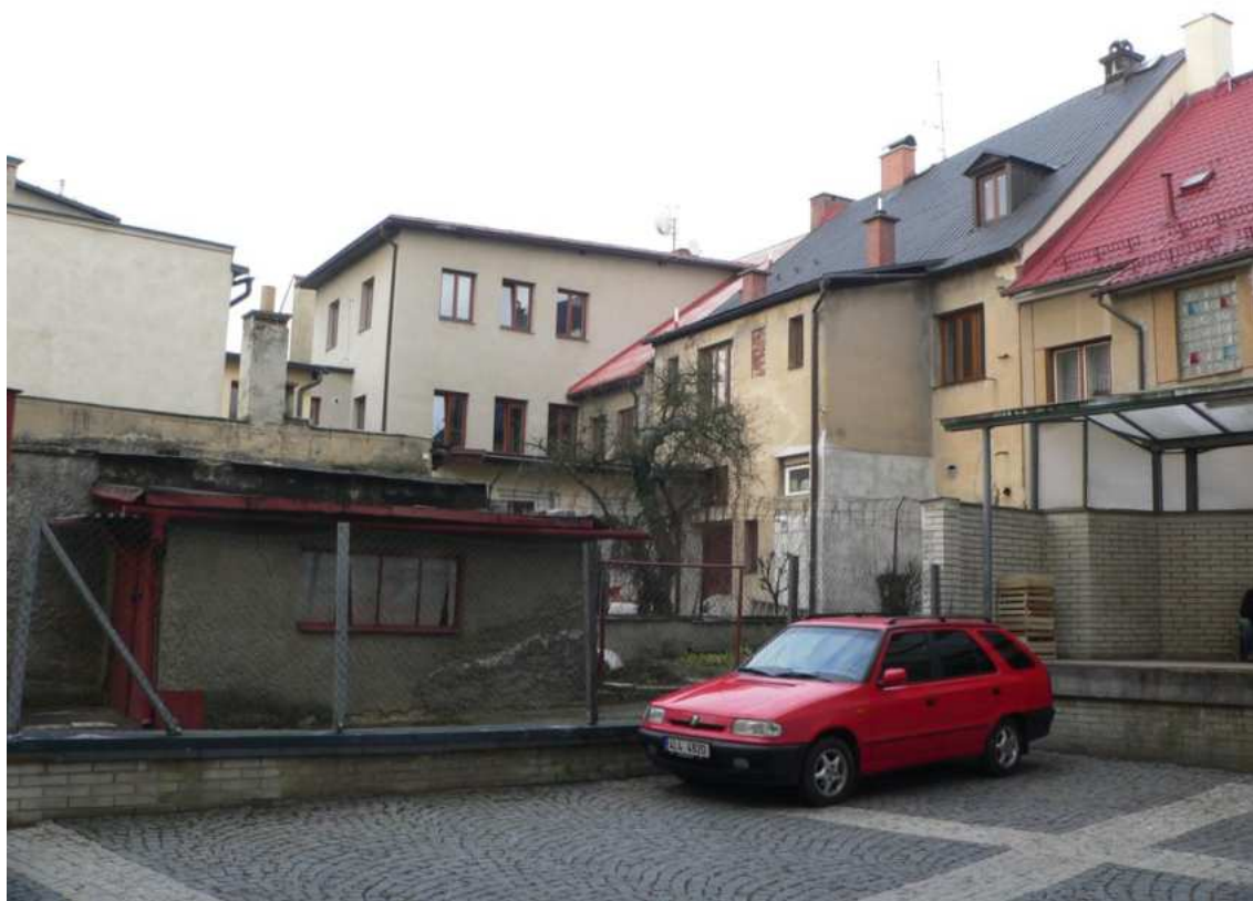
Dům č. p. 89, u zadního průčelí novodobá rozměrná přístavba s pultovou střechou, foto MK 2013.
