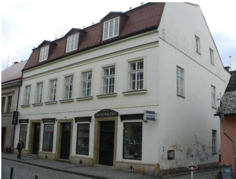
Dům č. p. 88, hlavní východní průčelí, foto MK 2013.
