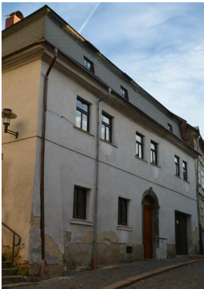
Dům č. p. 98, hlavní západní průčelí, foto IP 2013.
