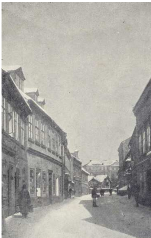
Průčelí domu č. p. 90 (druhé zleva) kolem roku 1900, (foto sbírka MČR, inv. č. AFT 177 a).
