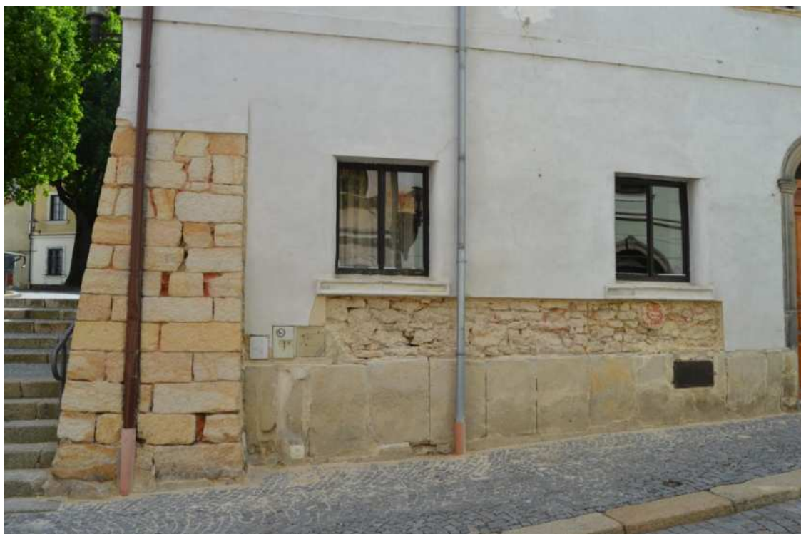
Dům č. p. 98, hlavní západní průčelí, detail opěráku z kvádrů, lomového obvodového zdiva a soklu z kamenných desek, foto IP 2015.
