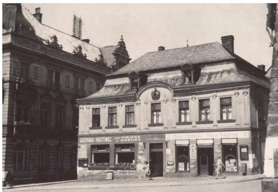
Průčelí domu č. p. 93 v roce 1944, (foto sbírka MČR, inv. č. AFT 179_2009-02).
