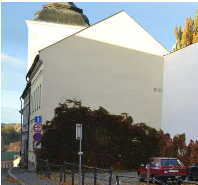
Dům č. p. 1425, štítové jižní průčelí, foto IP 2013.
