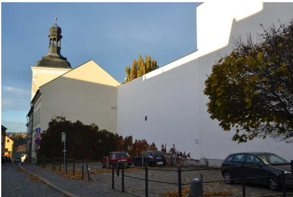
Nezastavěná parcela po zdemolovaném domě č. p. 96, foto IP 2013.
