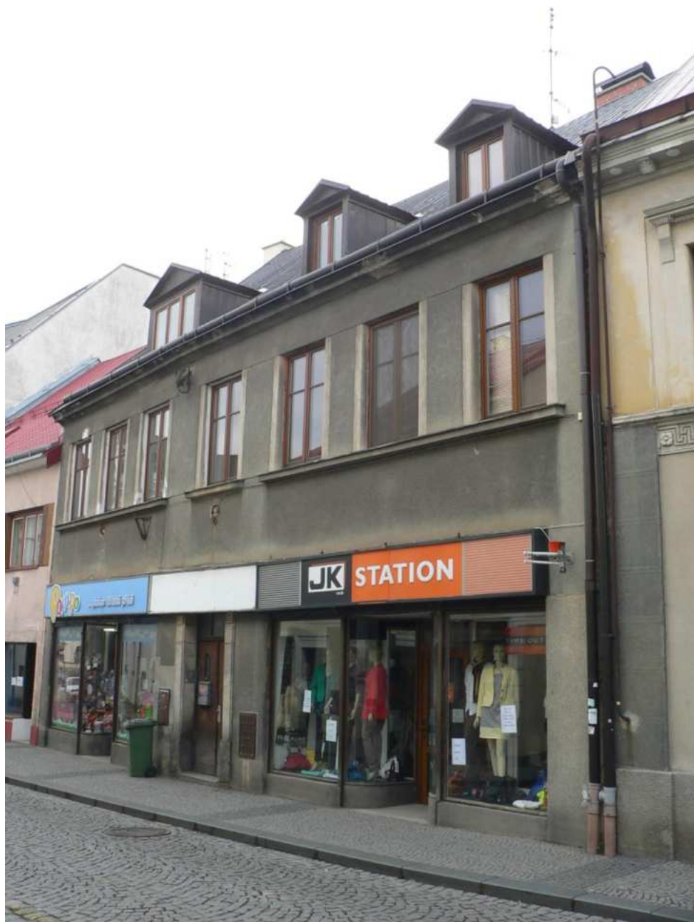
Dům č. p. 90, hlavní východní průčelí, foto MK 2013.
