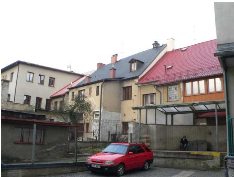
Dům č. p. 91, zadní západní průčelí (první zprava), foto MK 2013.
