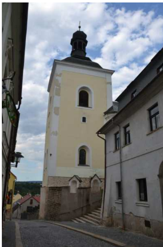
Kostel sv. Mikuláše, jižní průčelí věže, foto IP 2012.
