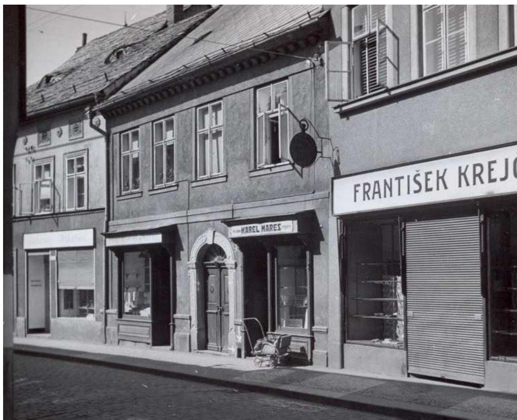
Průčelí domu č. p. 91 (druhé zprava) v roce 1944, (foto sbírka MČR, inv. č. AFT 179_2009-02).
