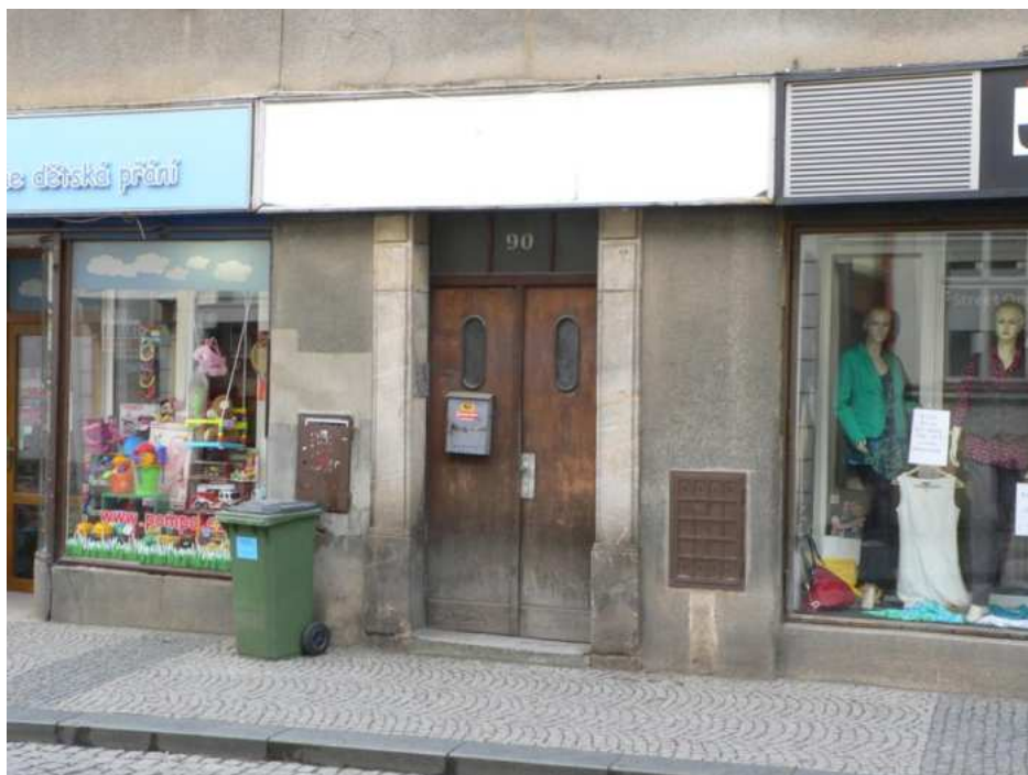
Dům č. p. 90, hlavní východní průčelí, detail portálu, foto MK 2013.
