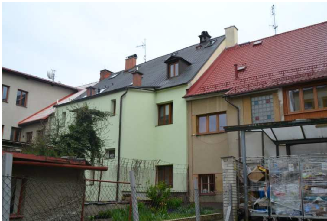
Dům č. p. 90, zadní západní průčelí (druhé zprava), foto IP 2016.
