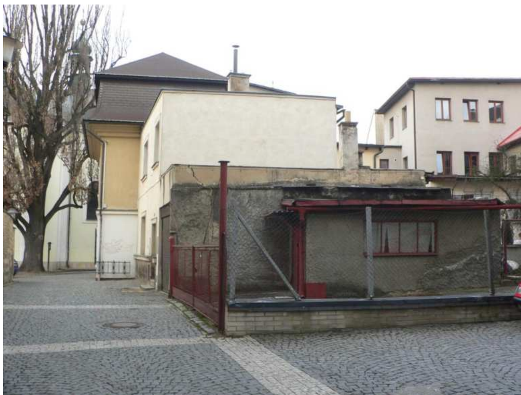
Dům č. p. 882, boční jižní průčelí, foto MK 2013.
