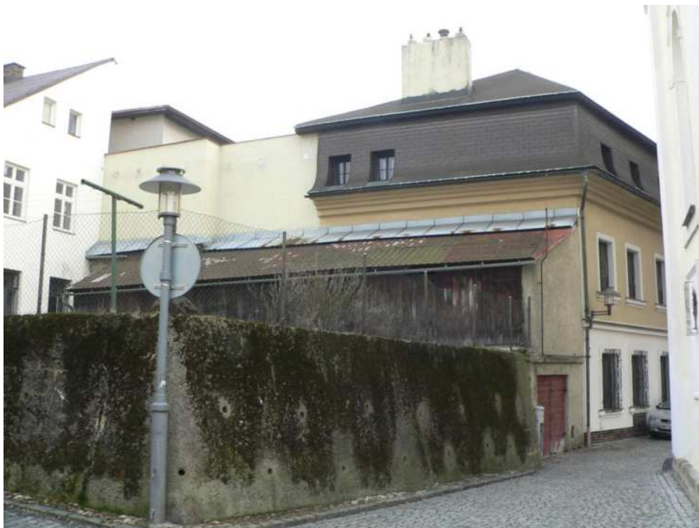
Dům č. p. 408, severní průčelí, foto MK 2013.
