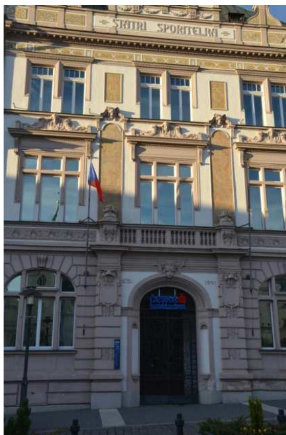
Dům č. p. 94, detail fasády podlaží a vstupu u hlavního jižního průčelí, foto IP 2013.
