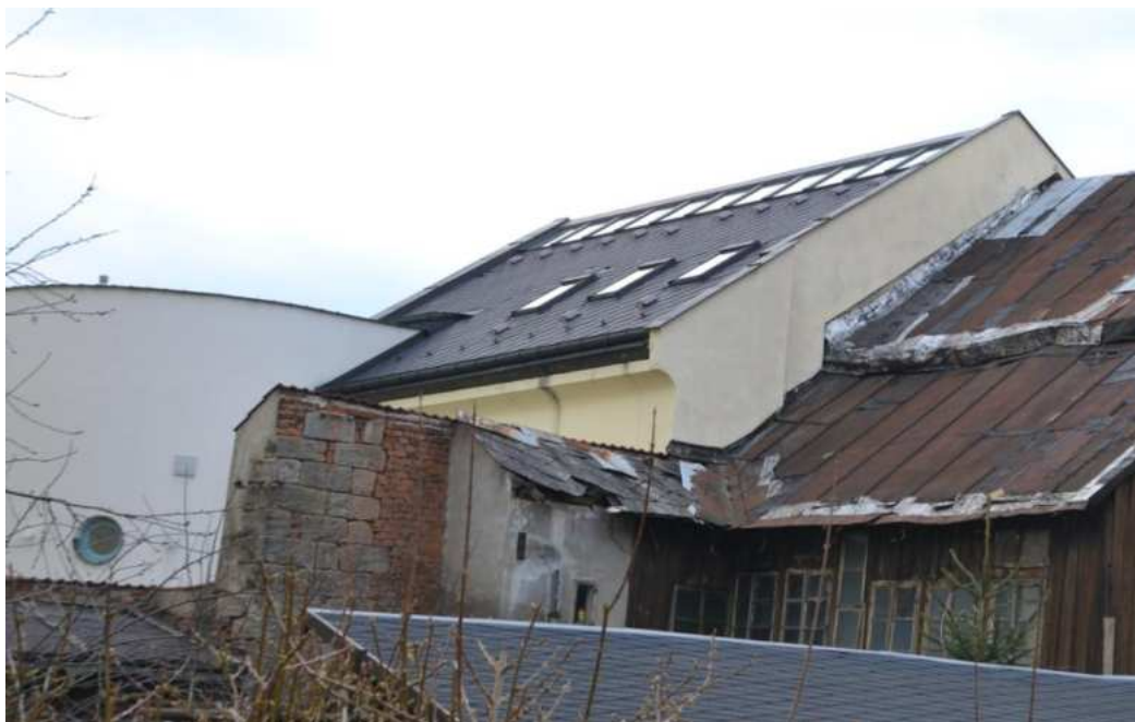
Dům č. p. 1425, štítové severní průčelí a zadní východní průčelí, foto IP 2013.
